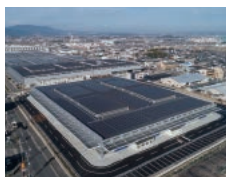
大和ハウス工業 奈良工場 奈良市西九条町4丁目2-2
