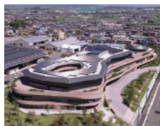
大和ハウスグループ みらい価値共創センター(コトクリエ) 奈良市西九条町4丁目1-1
